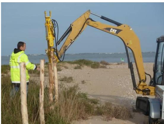
**Figure 26** : Pose de ganivelles à la pointe de l'Aiguillon en octobre 2012
