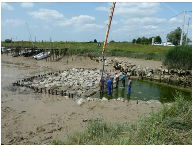
**Figure 31** : coulage du béton sur les nouveaux enrochements
